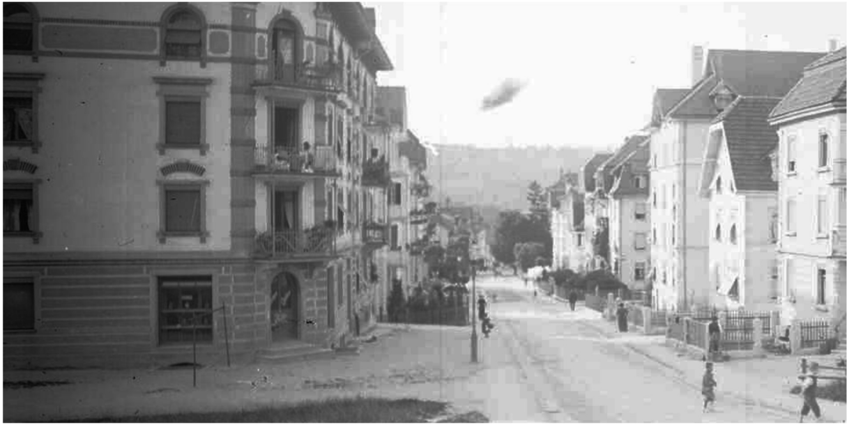
Röschstr. 16, 9000 St. Gallen (1915)
