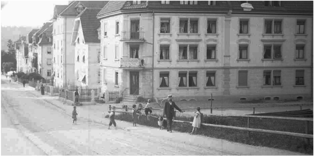
Röschstr. 15, 9000 St. Gallen (1915)
